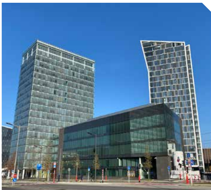
Gebouw EPPO in Luxemburg
